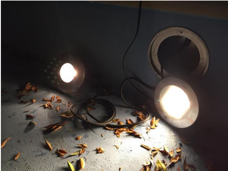
左: Panasonic製埋込型水中照明 (YAX73990)
